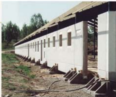
Prefabrykowane ściany upraszczają budowę obiektów inwentarskich.
