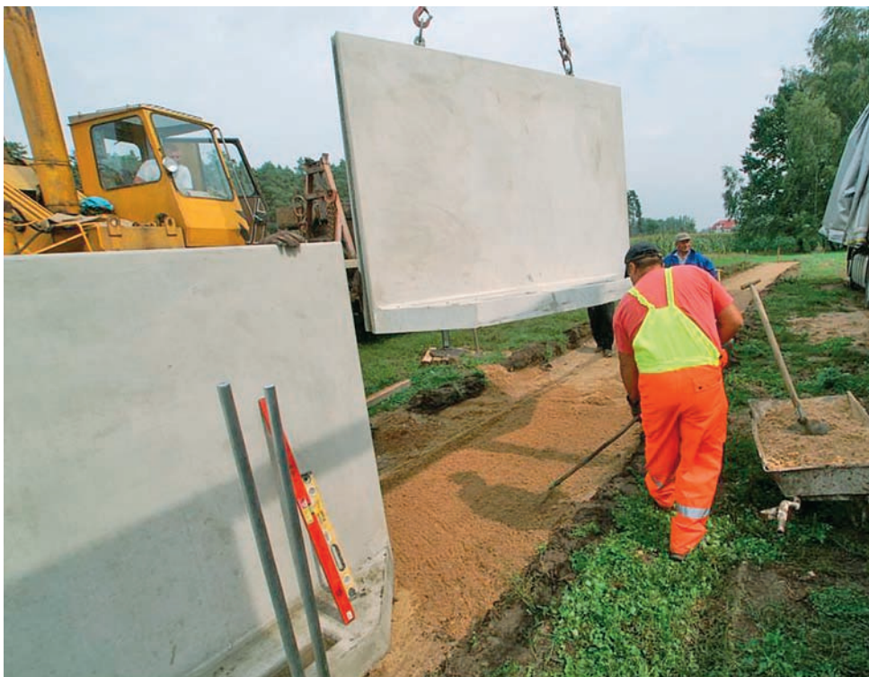
Prefabrykowane elementy silosu ustawia się na podsypce z piasku.
